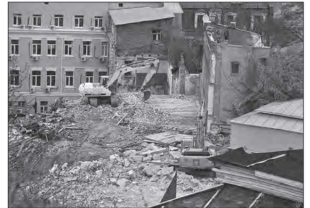
На Андріївському узвозі 10 квітня руйнують історичні будівлі. (Фото: Дмитро Стаховський)
